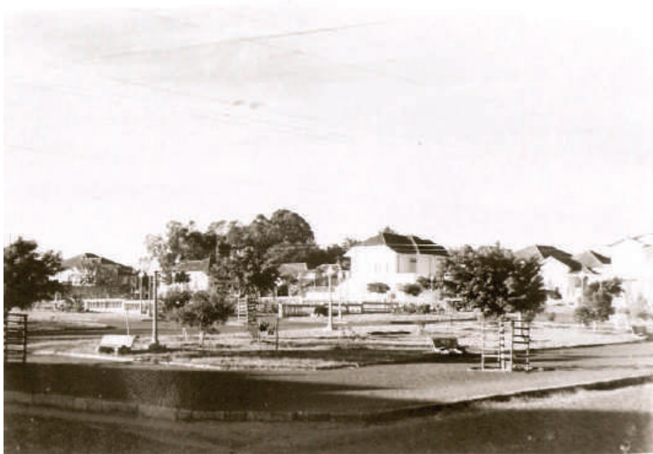
Foto da Praça 15 de novembro finalizada e com o início da arborização. Fonte: Acervo Fundação Pró-memória de São Carlos.
