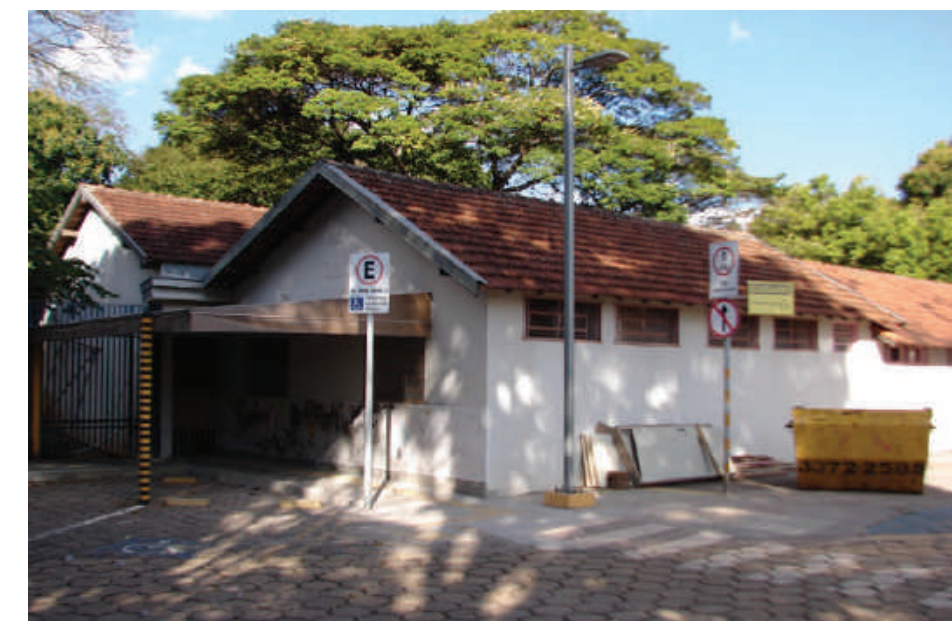
Entrada da Creche e Pré-escola São Carlos, 2021. Fonte: Foto do autor.
