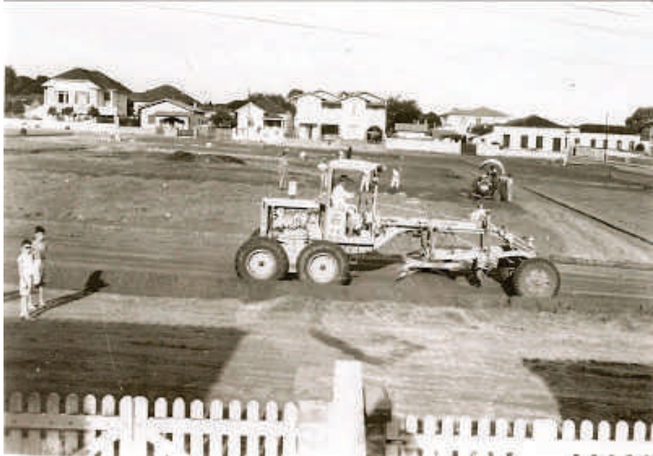
Construção da Praça 15 de novembro. 1951. Fonte: Acervo Fundação Pró-memória de São Carlos.
