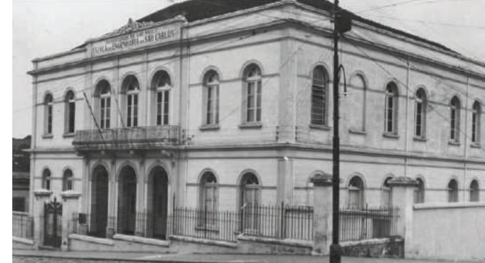
Antigo edifício da Casa d'Itália, na época já como Escola de Engenharia de São Carlos. Fonte: CDCC/Memórias do CDCC.
